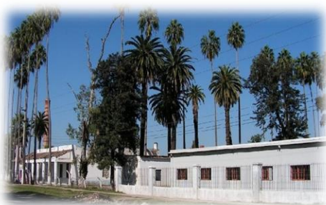
Vista lateral de Escuela Técnica N° 1 de Ranchillos (año 2008)
